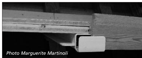
Un plateau de couchette avec son support (blanc) et une des glissières qui permet de ranger tables et bancs. A droite, planche amovible de retenue.
